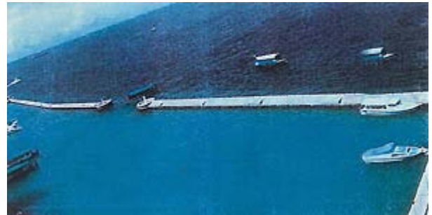
【写真】マレ島の周囲に建設された護岸(防波堤)
